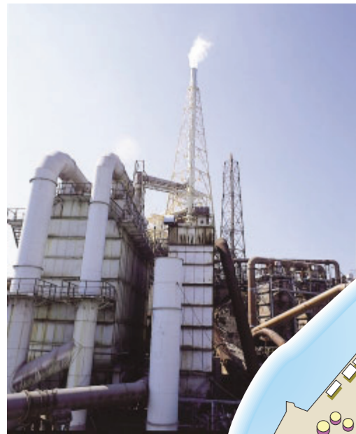
脱硫工場 De-sulfurization plant
