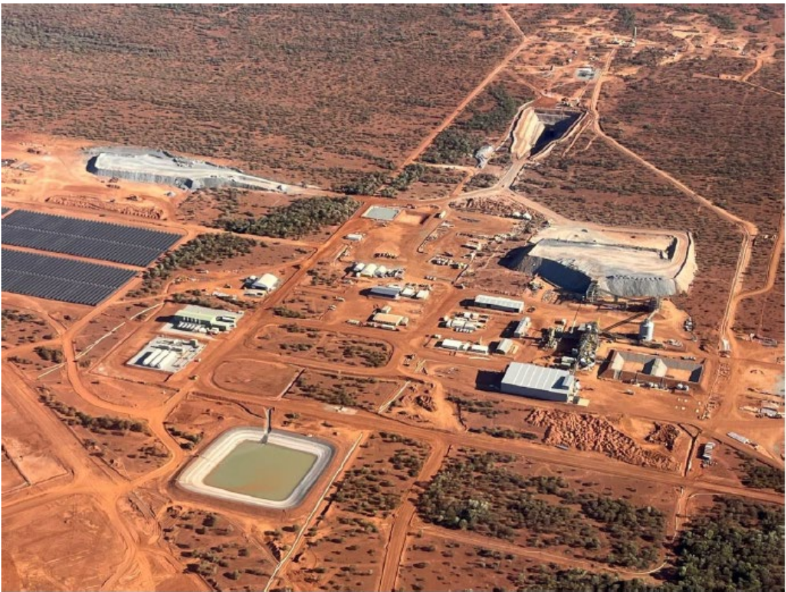
豪 Abra 鉛鋅山地上設備全景 (2022 年 11 月 11 日時点)
