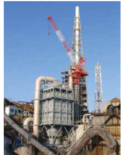
建設中の脱硫煙突用湿式電気集塵機 (2014年3月 契島製錬所)
