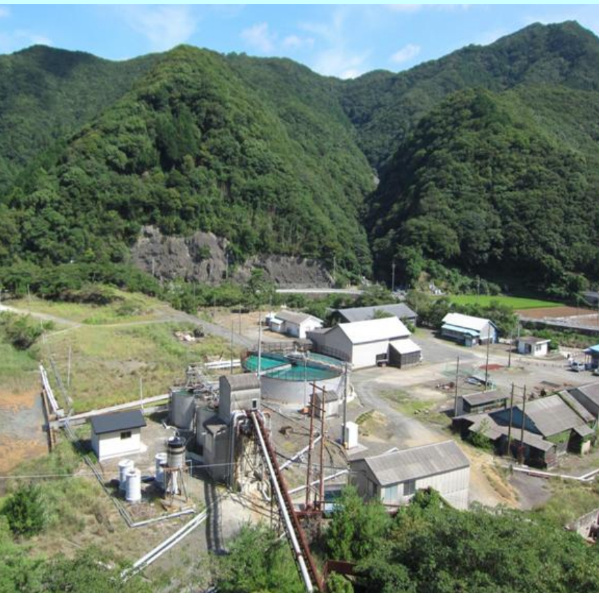
対州鉱山の坑廃水処理施設（長崎県）
