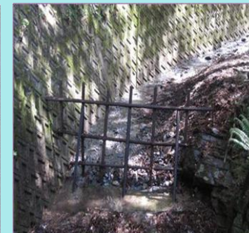
流木止め（復旧後）
