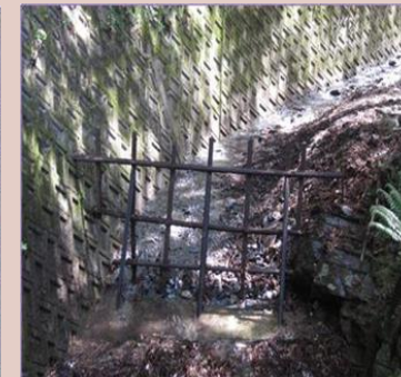
流木止め（復旧後）
