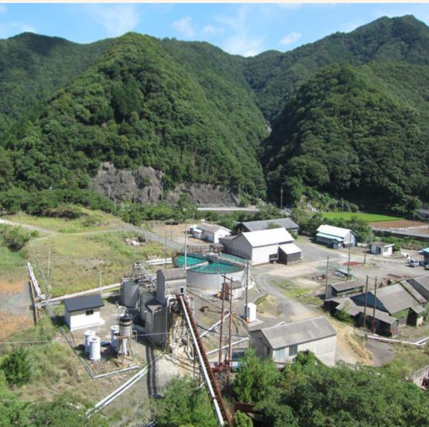
対州鉱山の坑廃水処理施設（長崎県）
