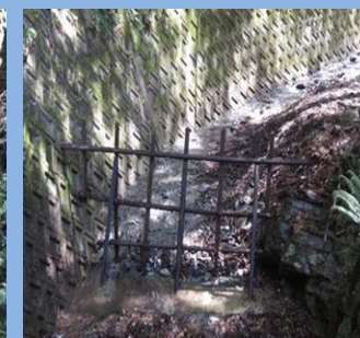
流木止め（復旧後）
