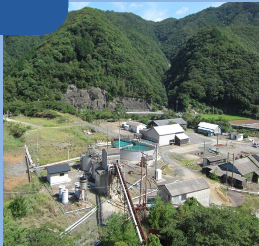
対州鉱山の坑廃水処理施設（長崎県）
