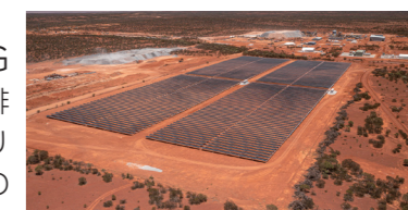
Abra 鉱山 Solar Farm
