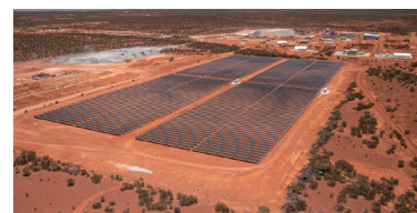
Abra 鉱山 Solar Farm
